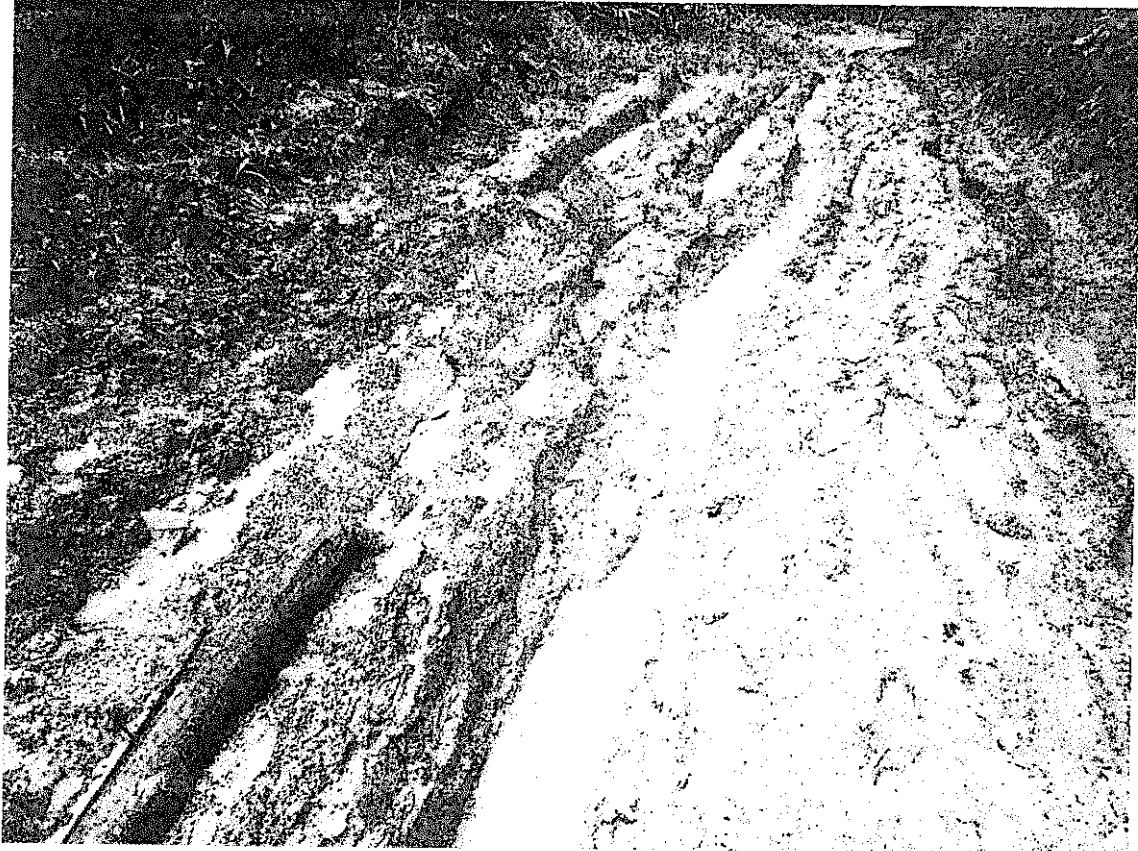
Foto2: Ahuellamientos en la vía a consecuencia de falta de drenaje superficial y tipo de terreno
