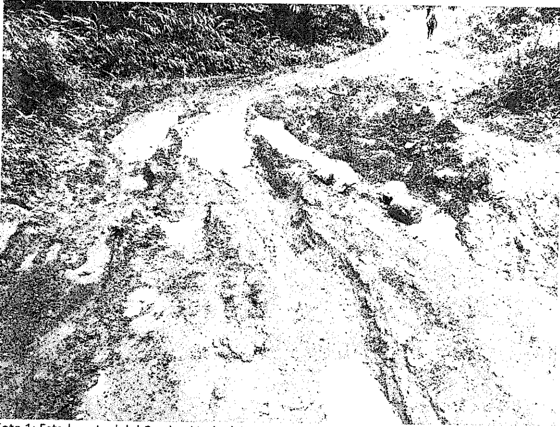
Foto 1: Estado actual del Camino Vecinal Progresiva 8+200
